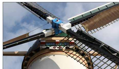
van links onder naar rechtsboven de binnenroede; van linksboven naar rechtsonder de buitenroede
